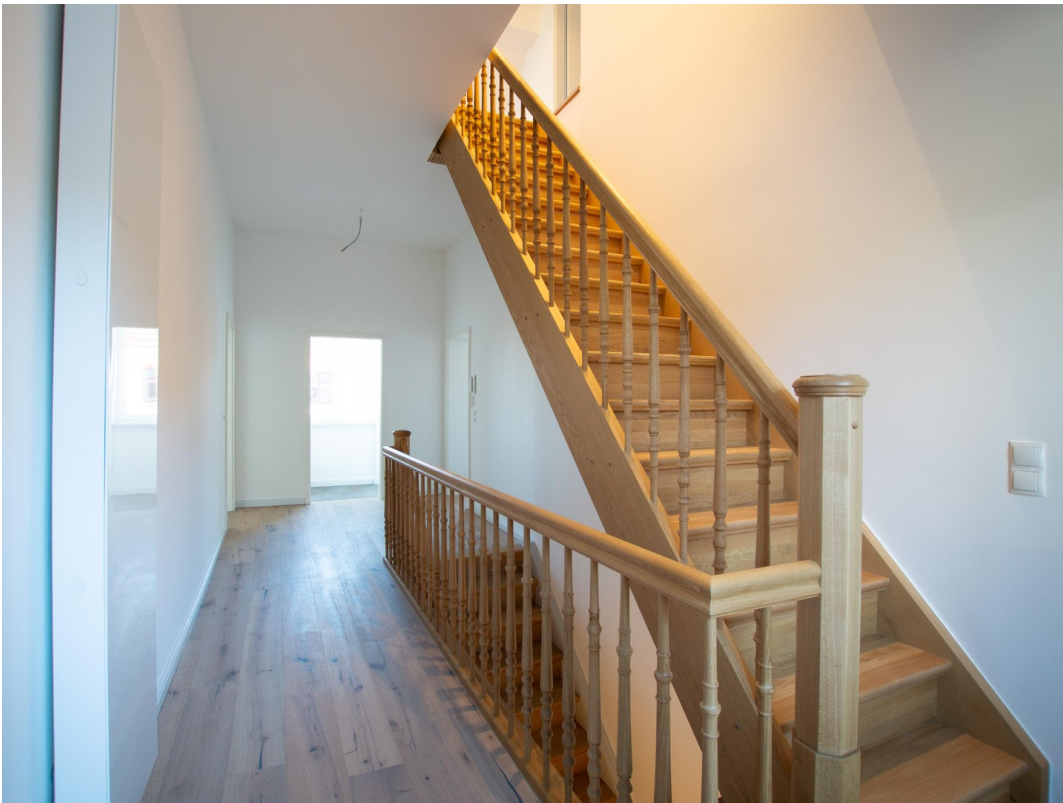
Flur OG zu DG
