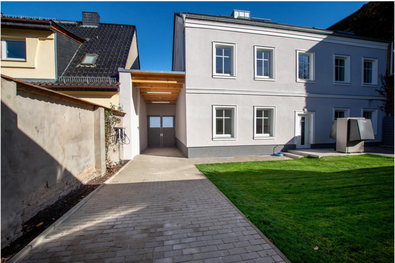
Hof-Ansicht mit Toreinfahrt
