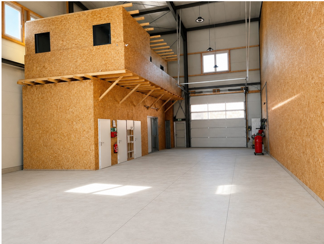
Halle Einbau und Tor 2
