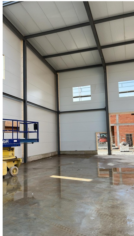
Halle o. Einbau
