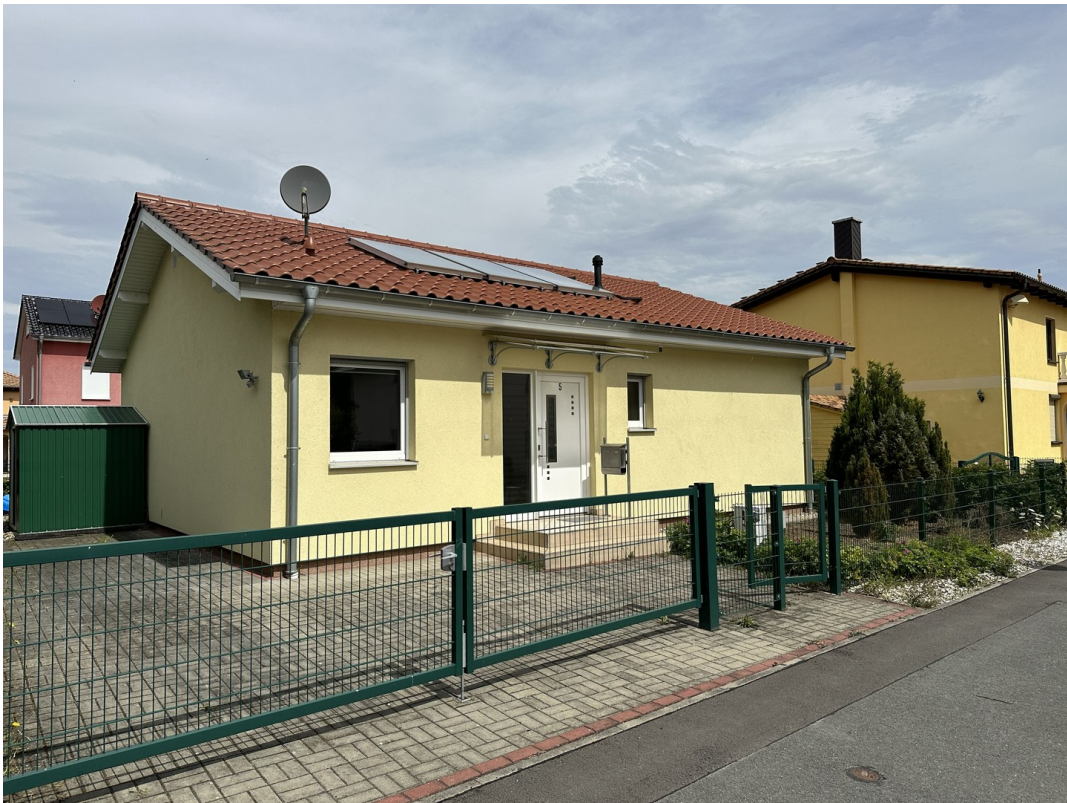
Das Haus von der Straßenseite
