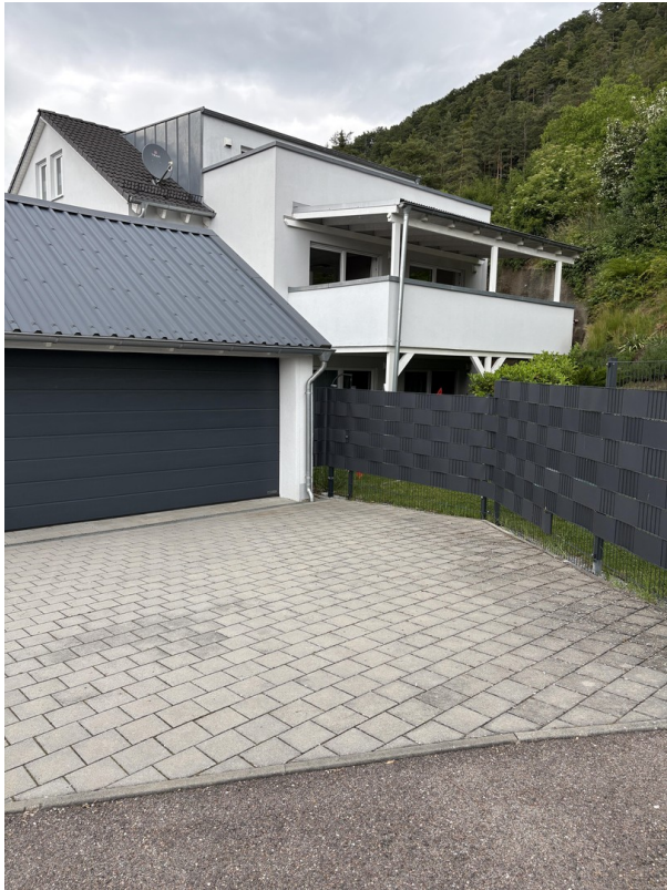
Blick zur Doppelgarage
