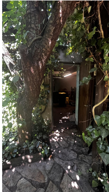
Eingang vom Garten zur Garage
