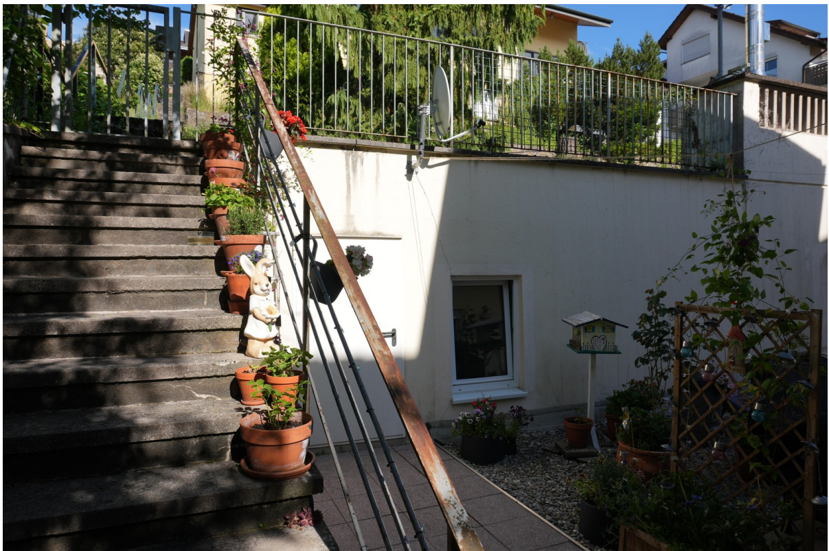
Zugang zum Abstell- und Keller
