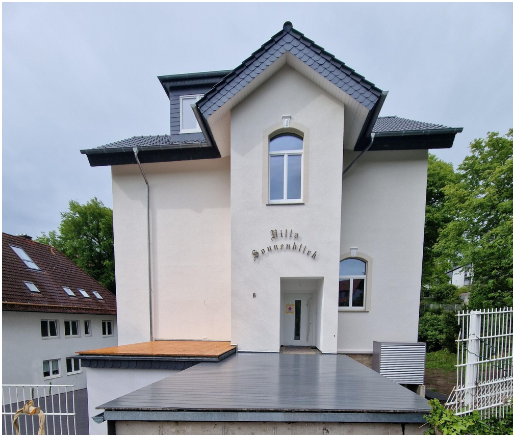
Eingang (noch ohne Geländer)
