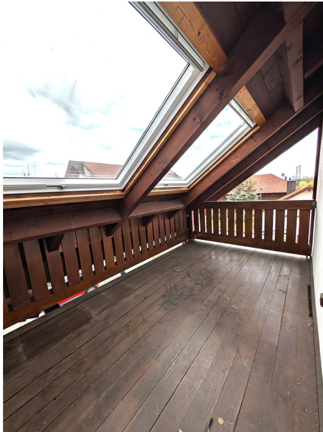
Überdachter Balkon Ist Zustand
