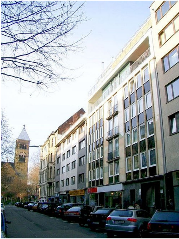
Gebäude aus den 1950ern ...
