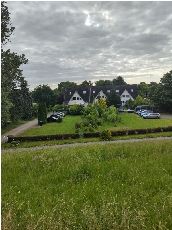
Außenansicht vom Deich aus
