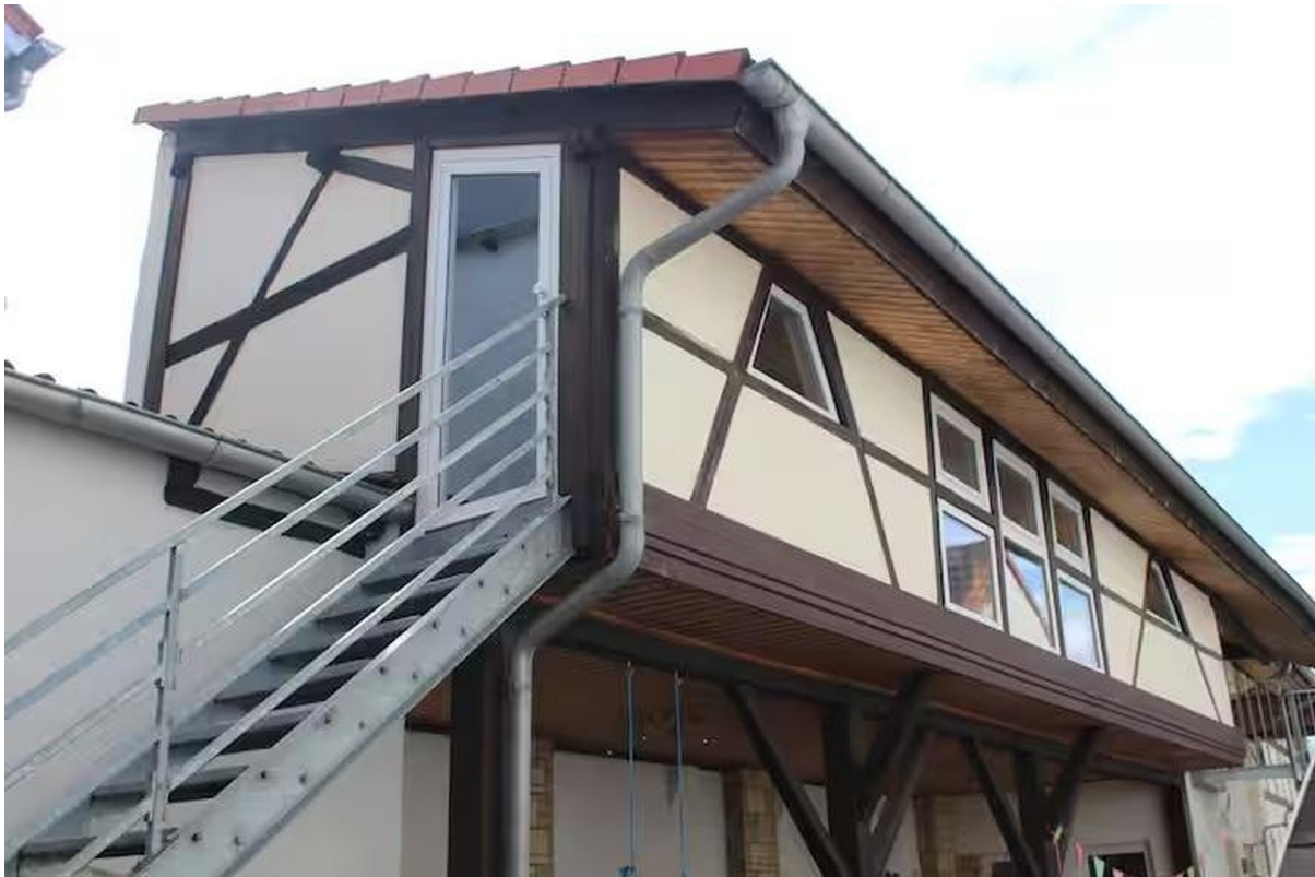
Anbau mit Bar darunter
