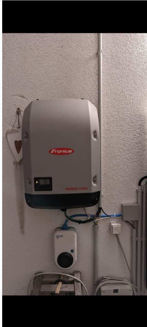
Wechselrichter PV-Anlage
