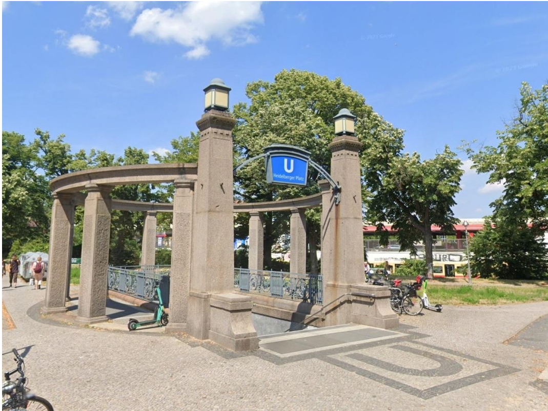
U3-Bahn Heidelberg Platz
