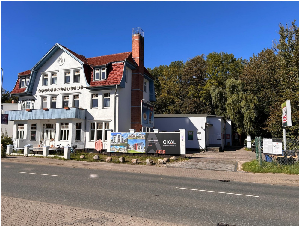
Auffahrt und Gewerbeobjekt
