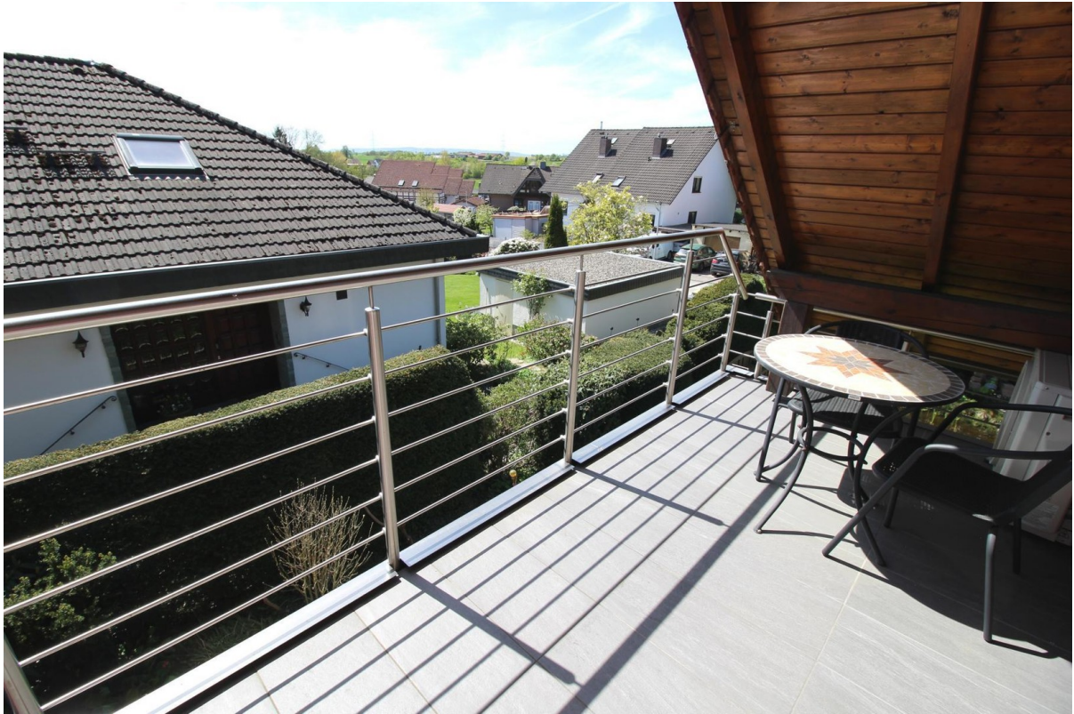
Südwest Balkon OG
