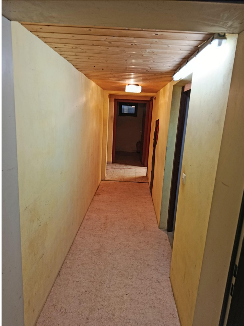
UG Keller Flur
