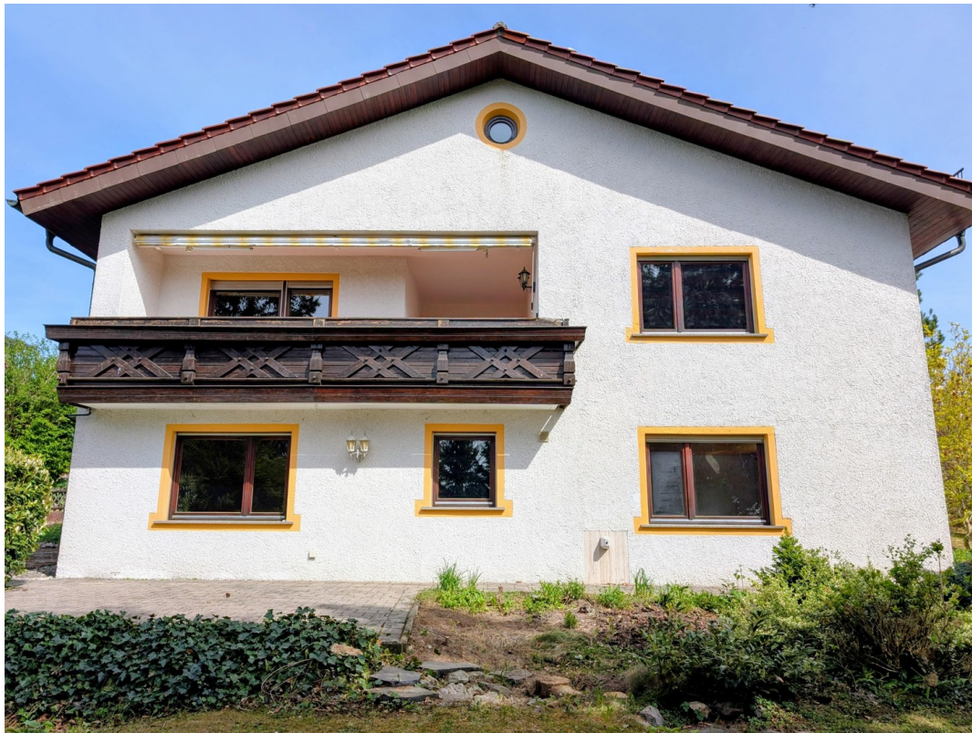
Blick auf Balkon und Terrasse
