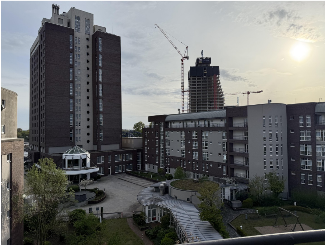
Ausblick Balkon mit Elbtower
