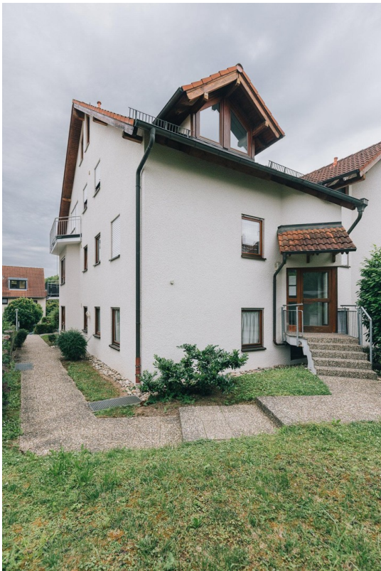
Blick auf den Hauseingang
