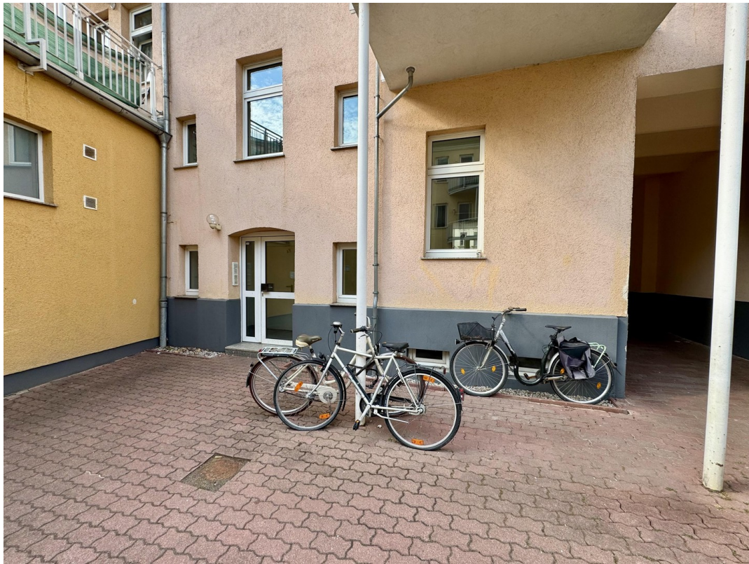
Hauseingang im Innenhof
