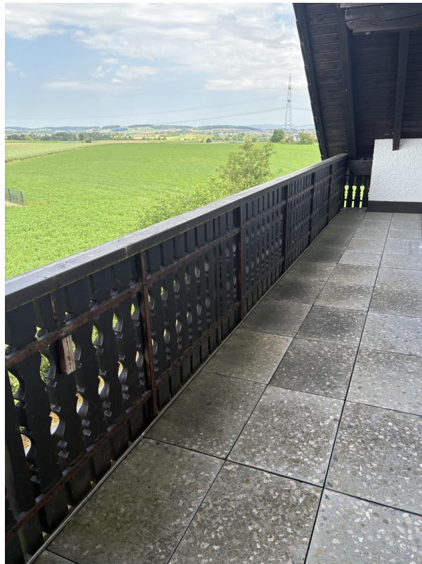
DG Balkon Westausrichtung
