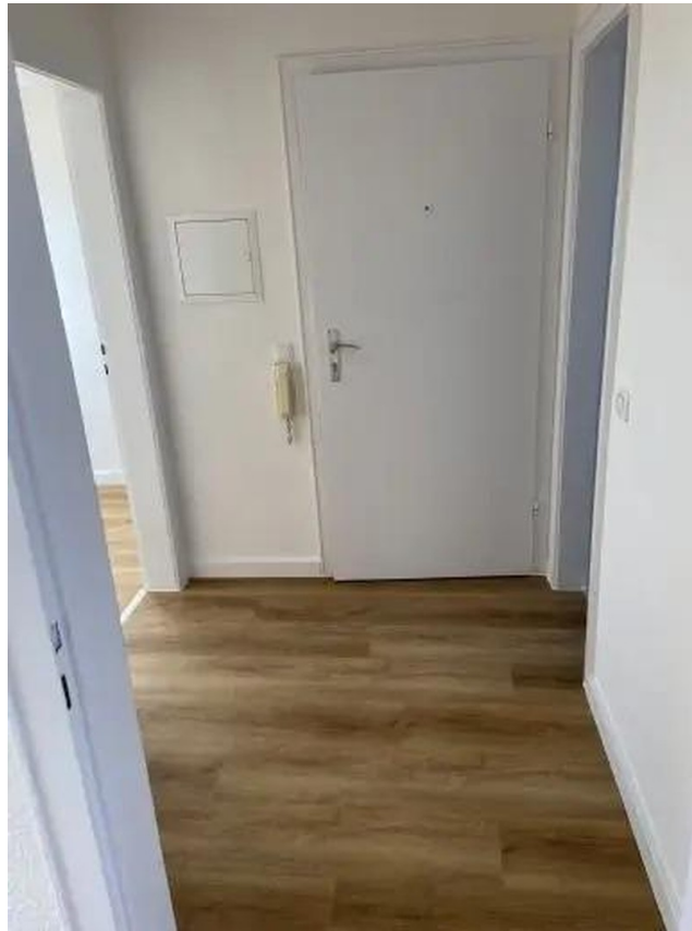
Eingang vom Treppenhaus, Flur
