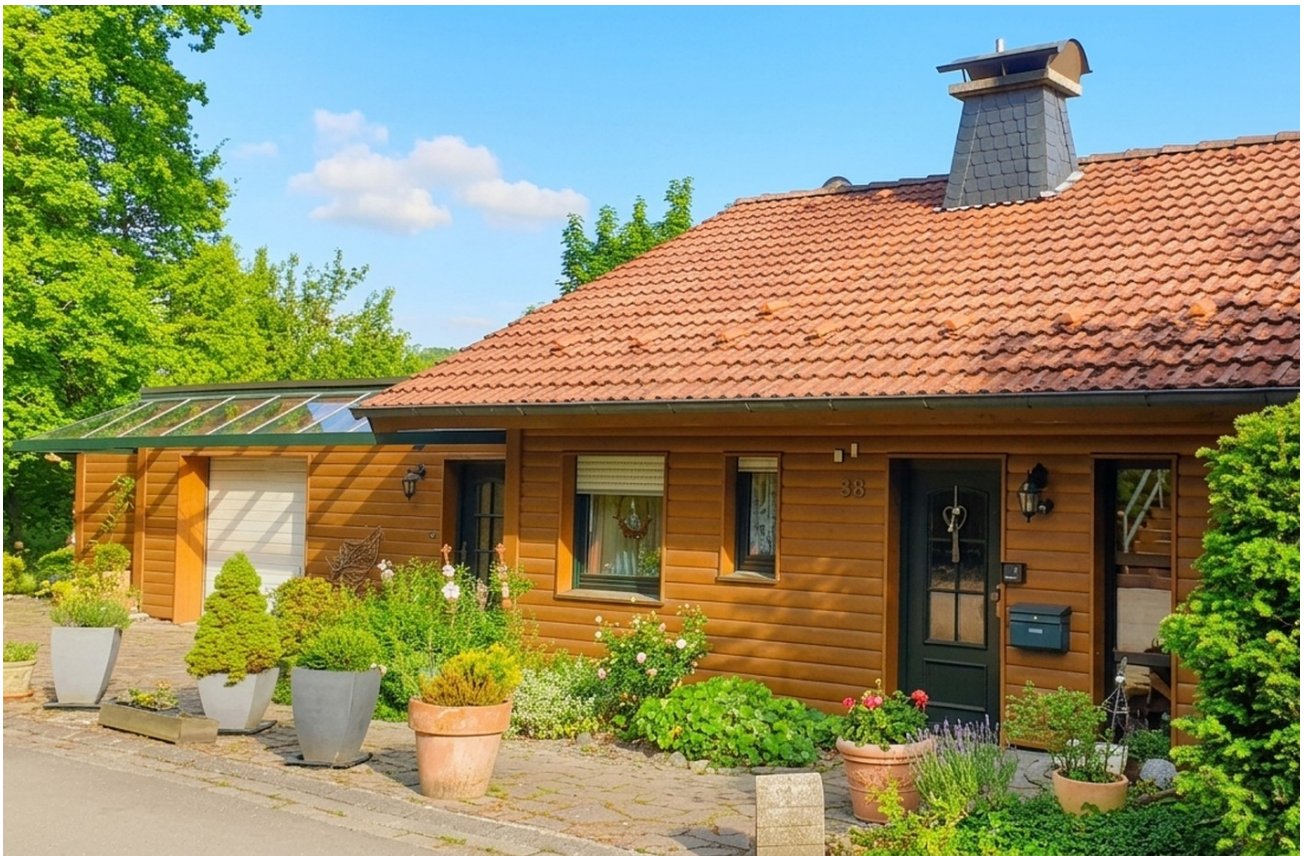
Frontansicht Haus mit Eingang
