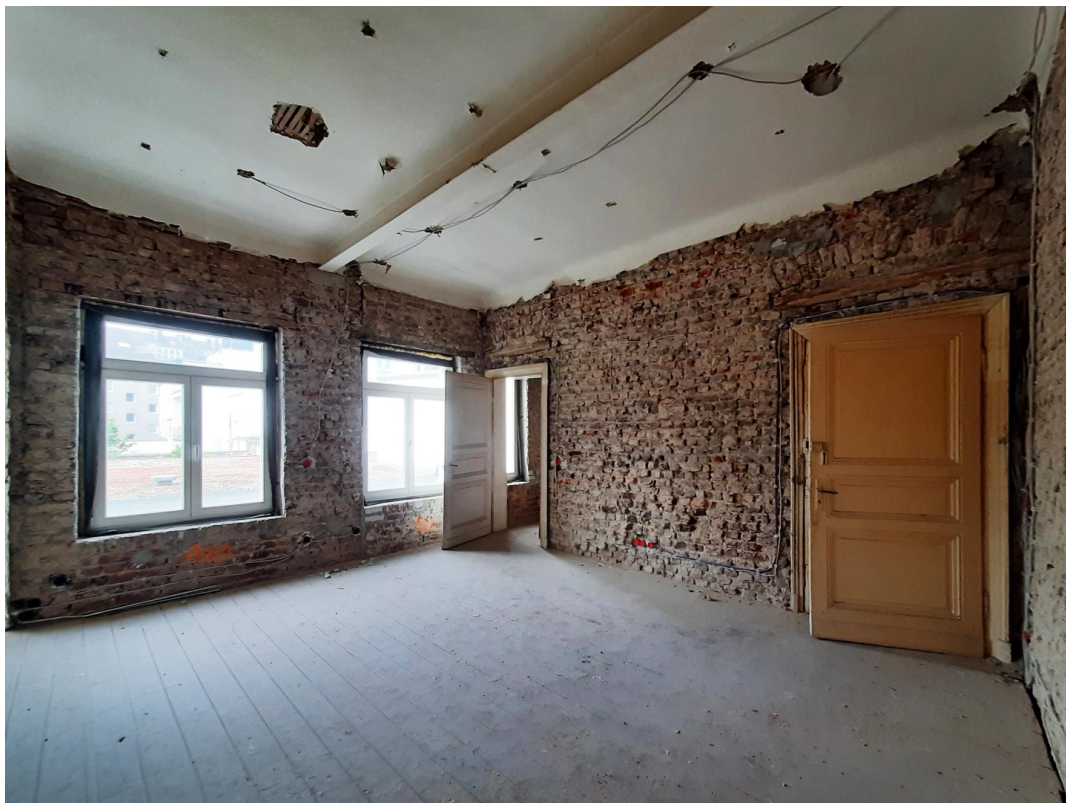
1.OG Arbeiten - IST-Zustand
