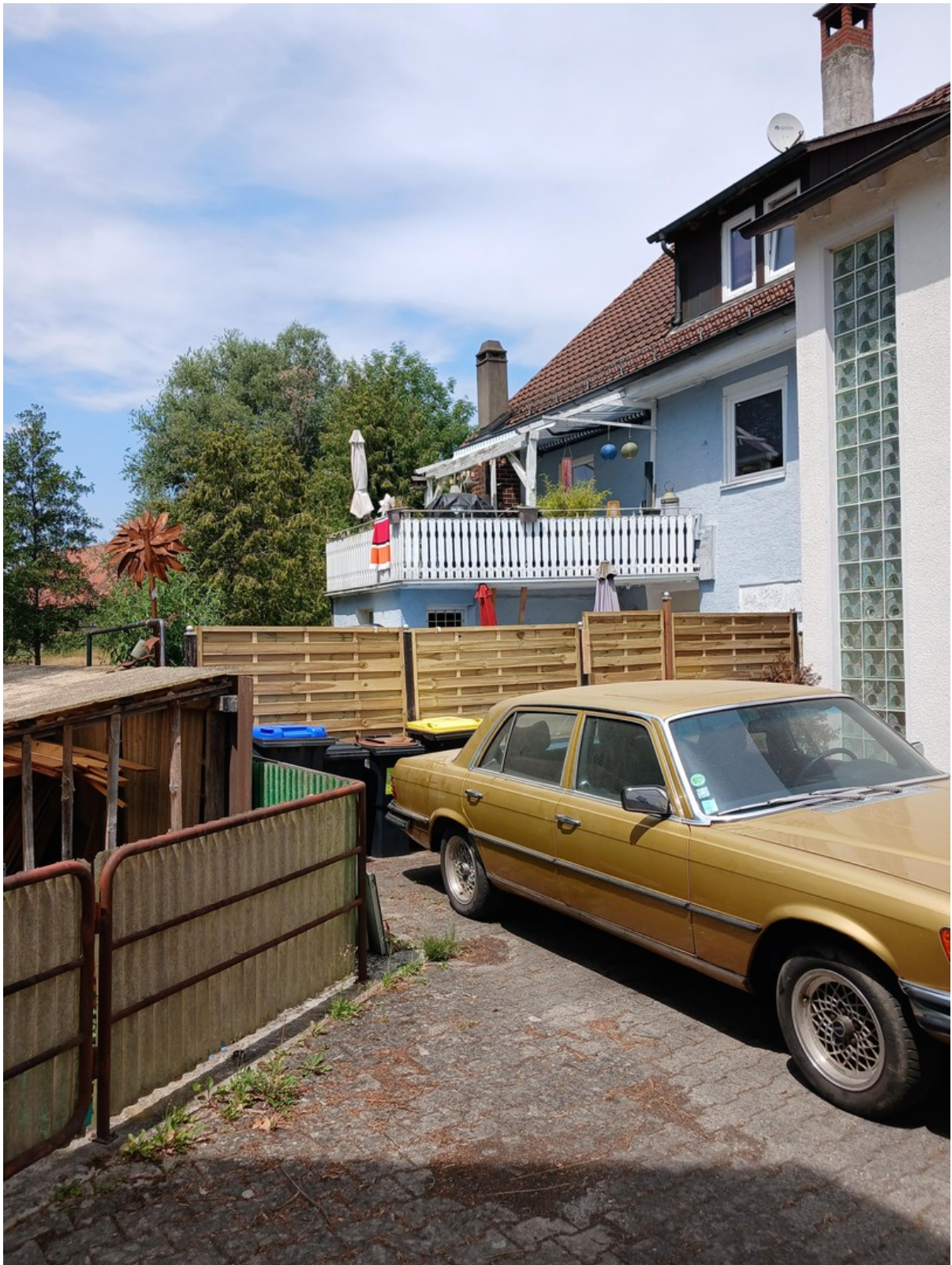
Ansicht Haus hinten
