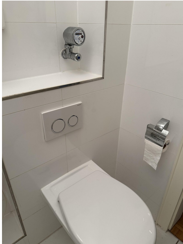
WC im Bad
