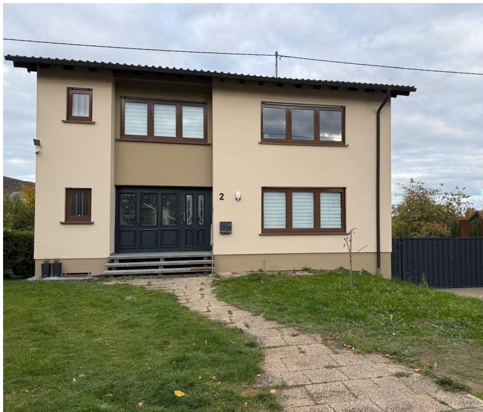
Modernisierte Außenansicht mit
