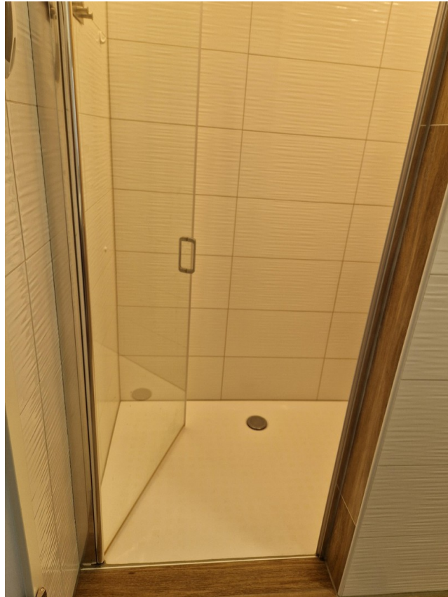
Hauptbad bodengleiche Dusche
