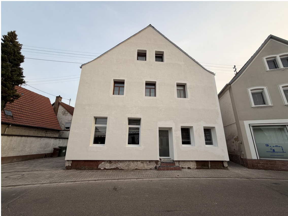
Außenansicht Haus+Einfahrt zu
