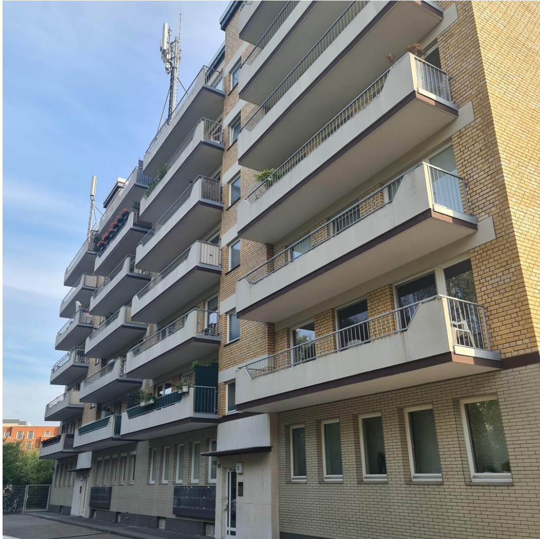
Aussenansicht vom Gebäude
