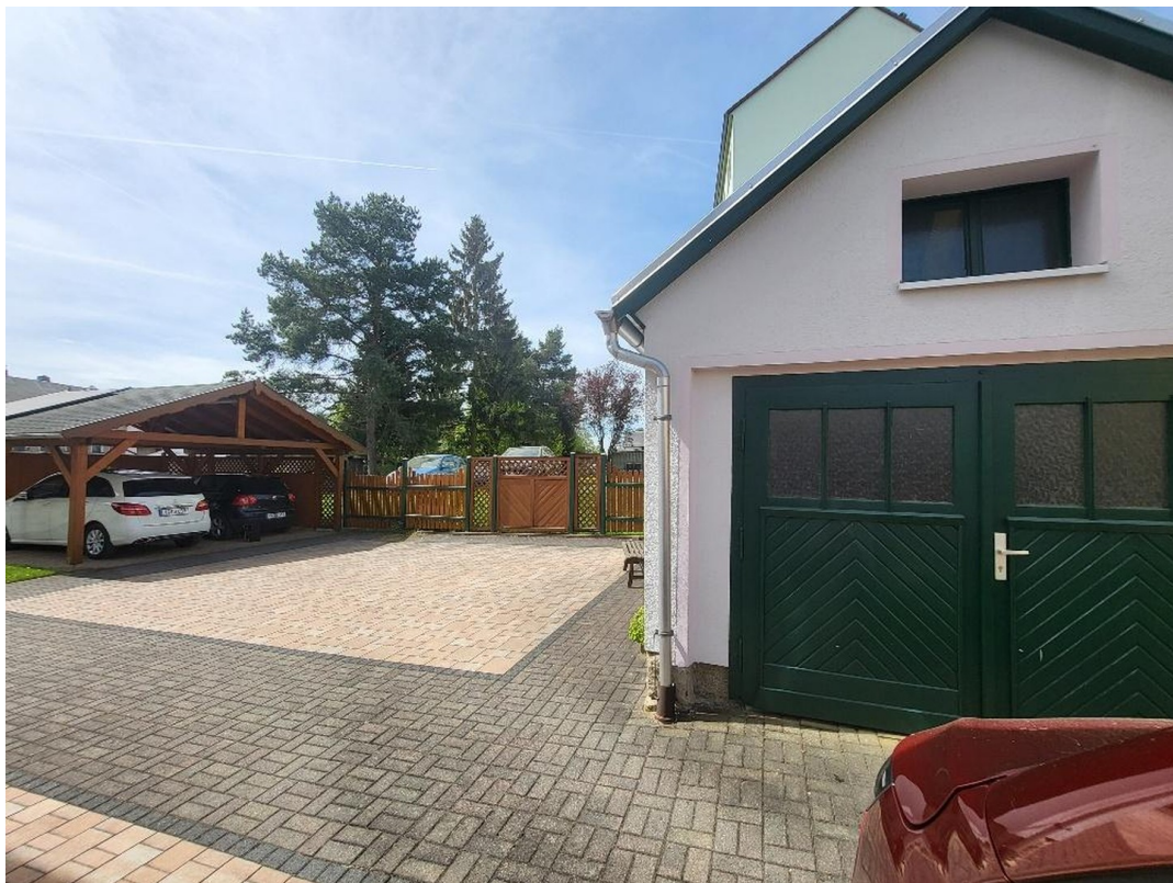
Garage und Doppelcarport
