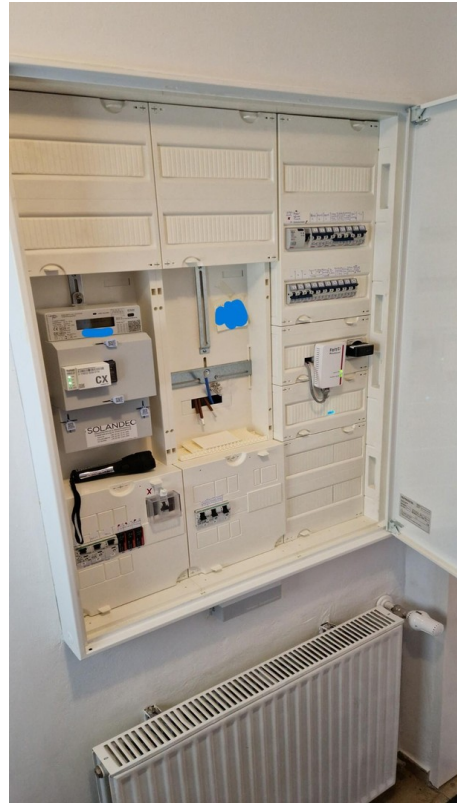
neuer Elektrok./Smartmeter
