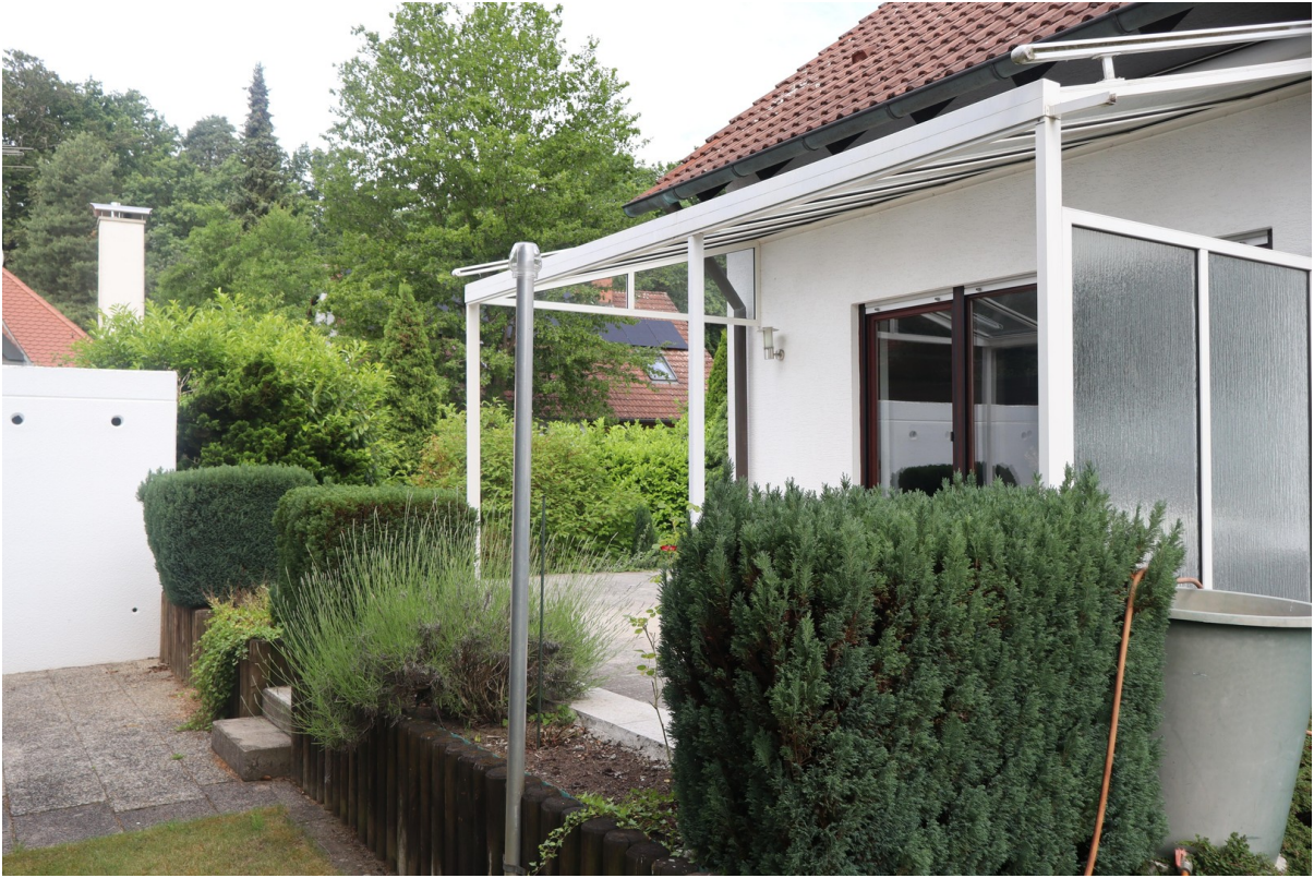
alles unter Dach und Fach
