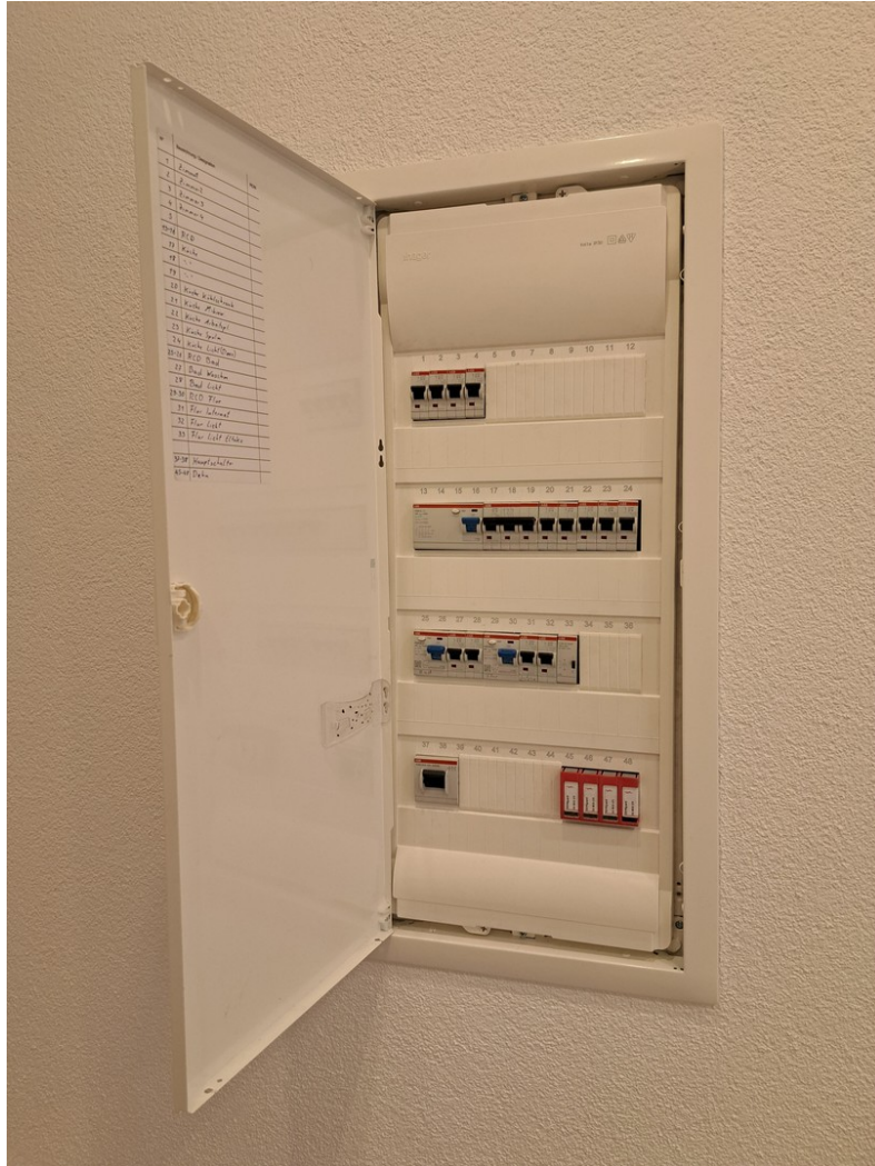
DG Unterverteiler
