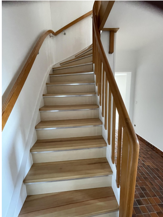
Treppe zum 1. Obergeschoß
