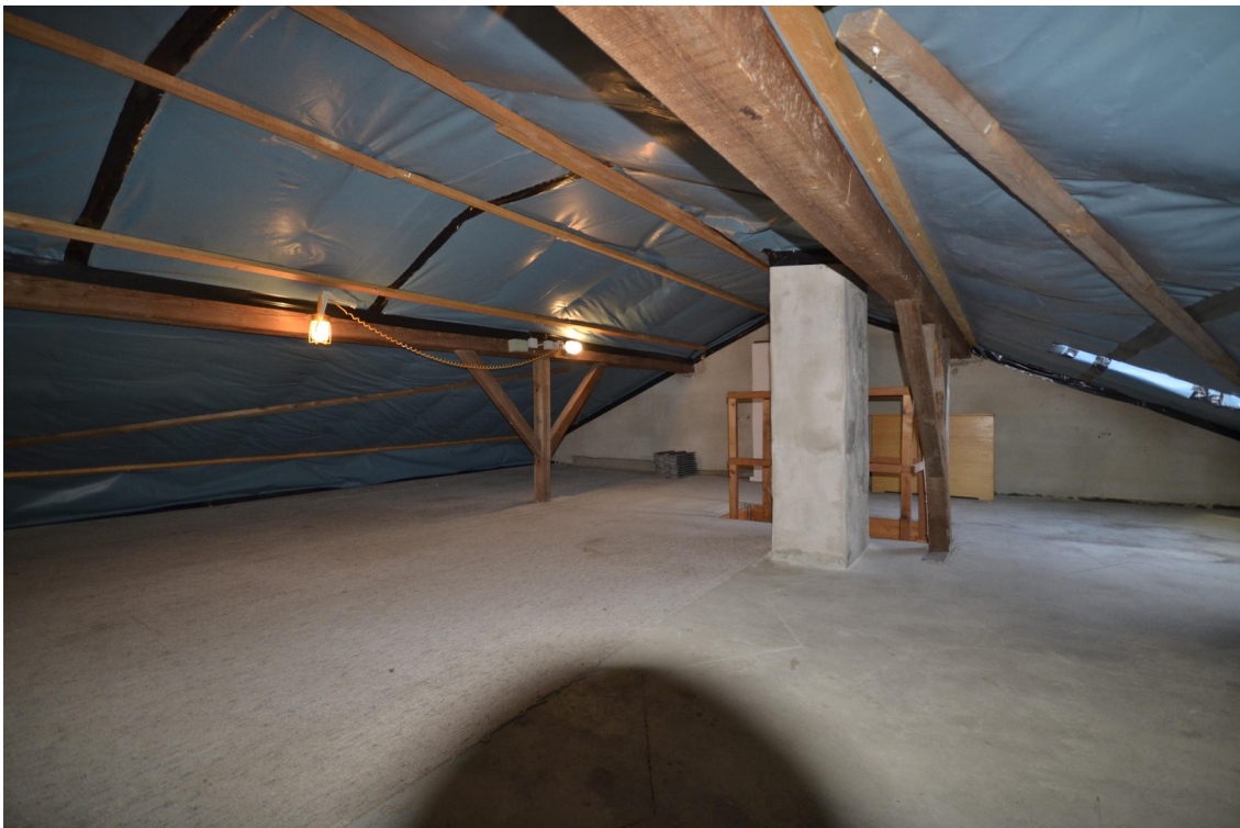
Speicher mit viel Nutzfläche
