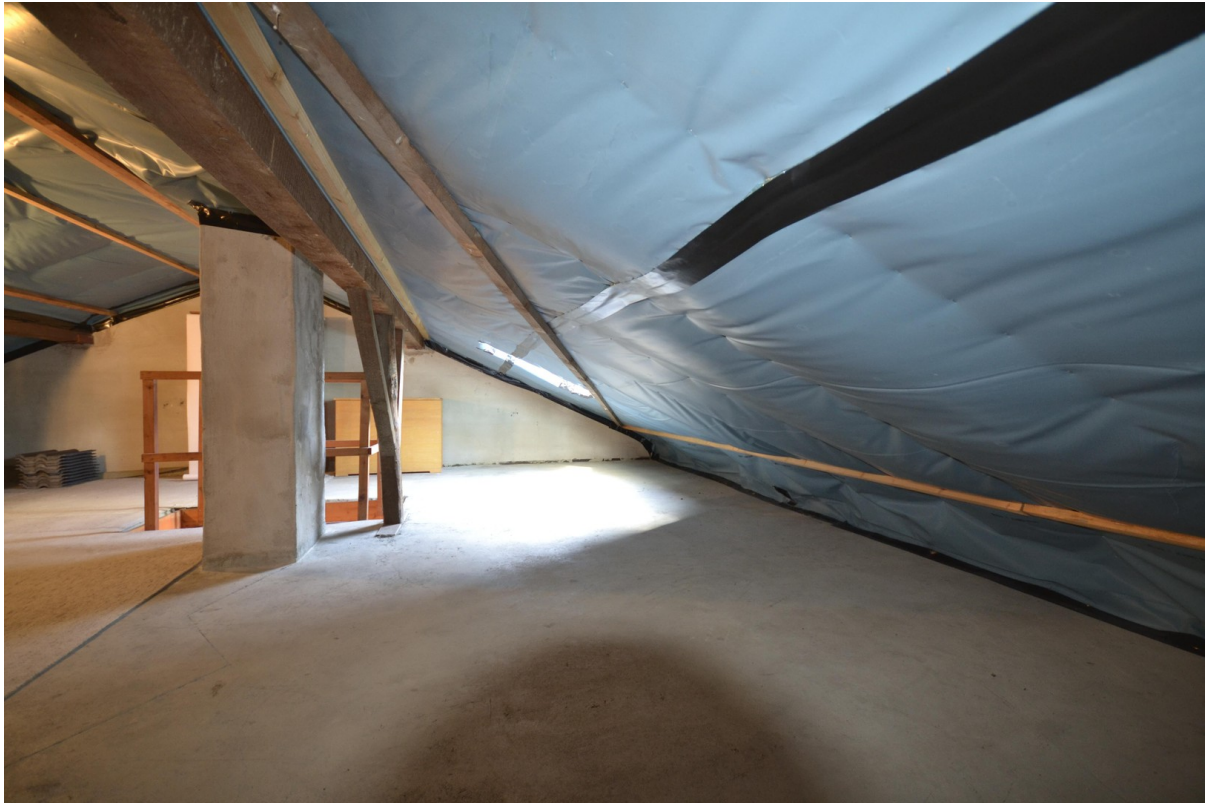
Speicher mit viel Nutzfläche
