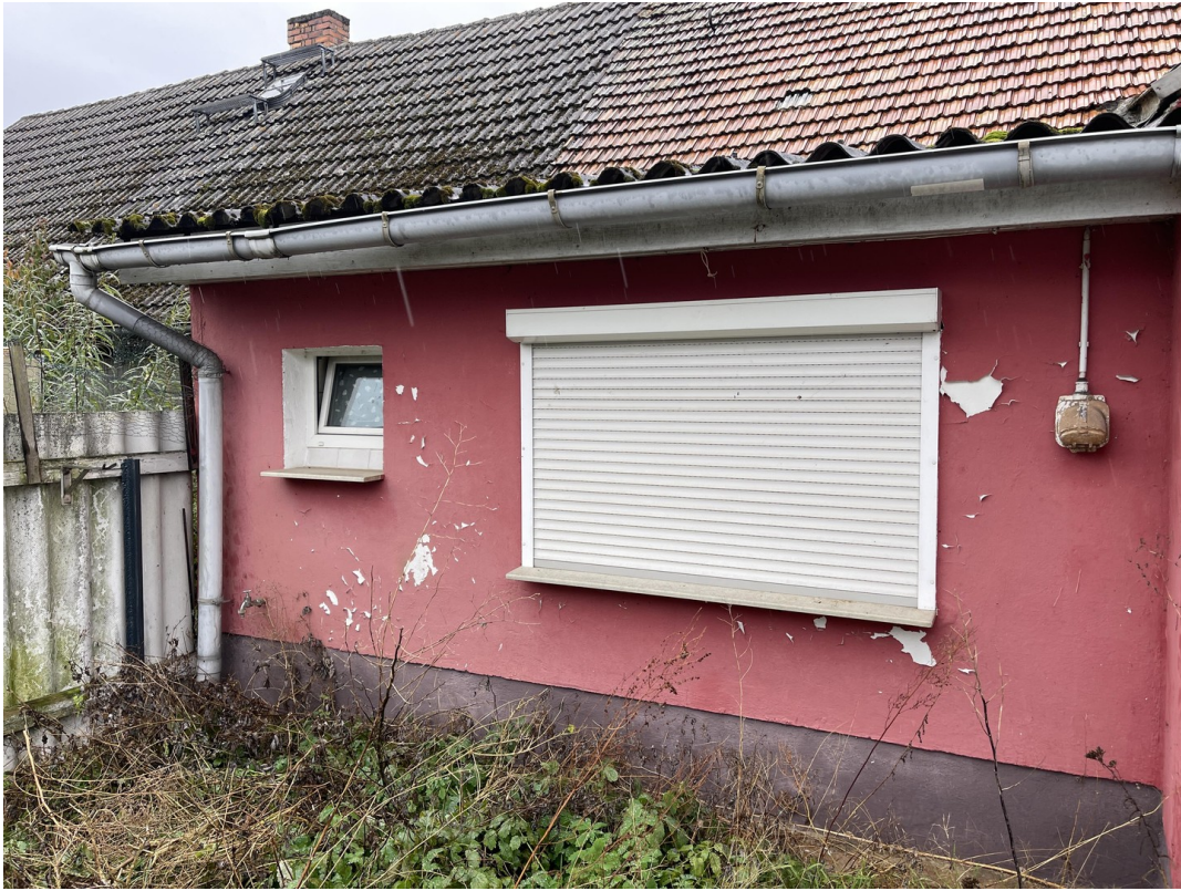
Fassade vom Garten 3
