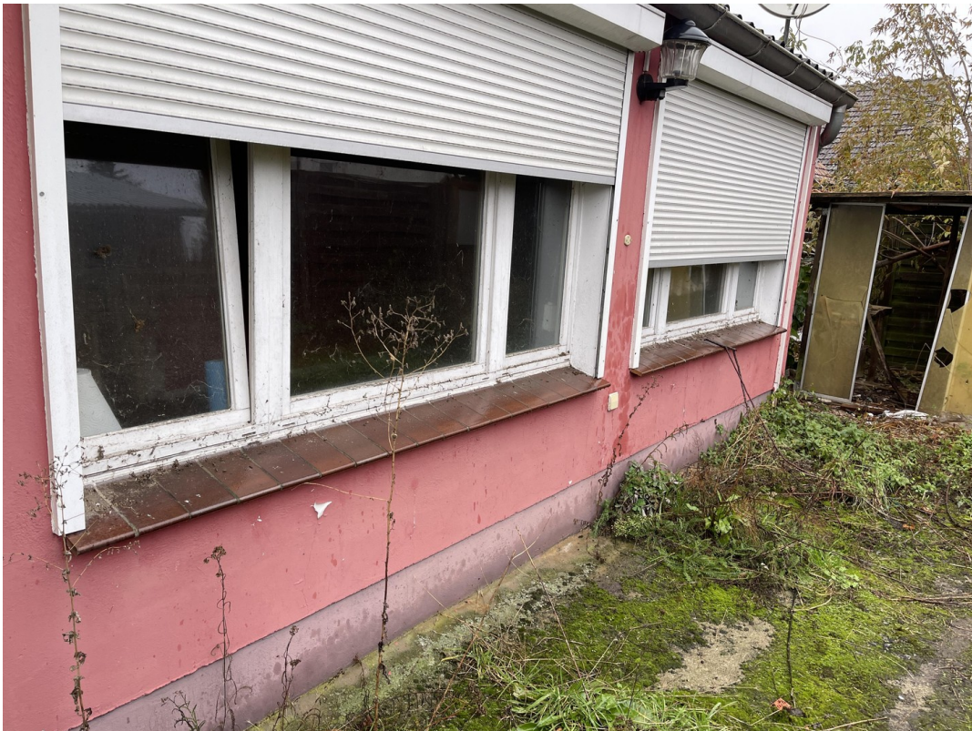
Fassade vom Garten 2
