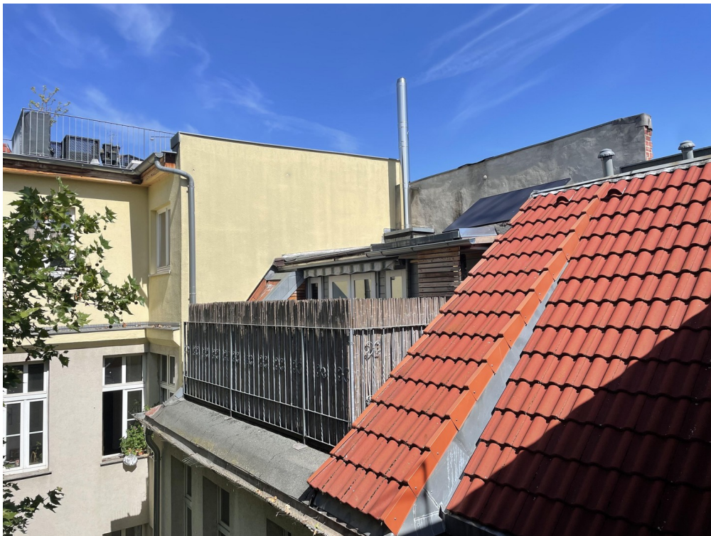
Dachterrasse vom Quergang
