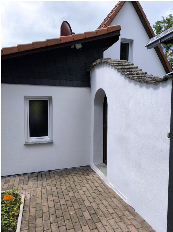
Zugang zur Garage
