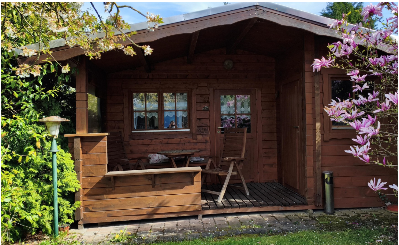
Blockhaus mit 2 Räumen
