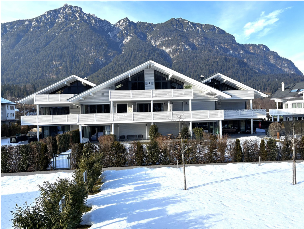
Südseite - gesamtes Refugium
