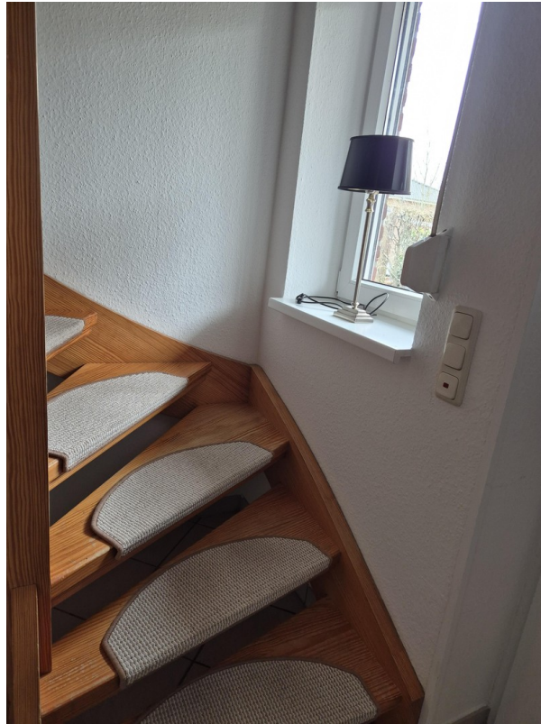
Treppenaufgang vom Flur EG
