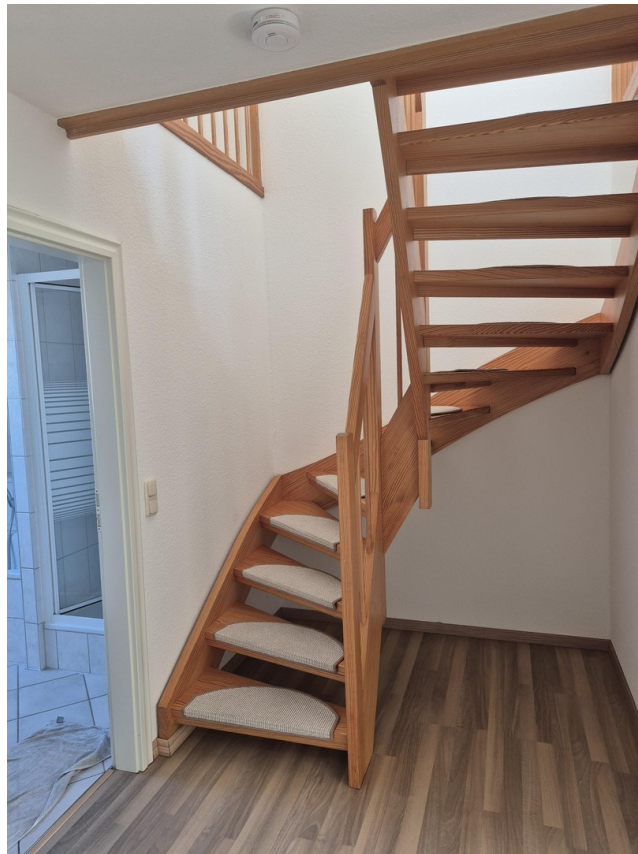
Treppe zum Dachgeschoss
