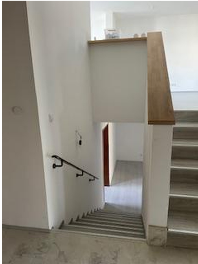
Blick Souterrain + Wohnzimmer
