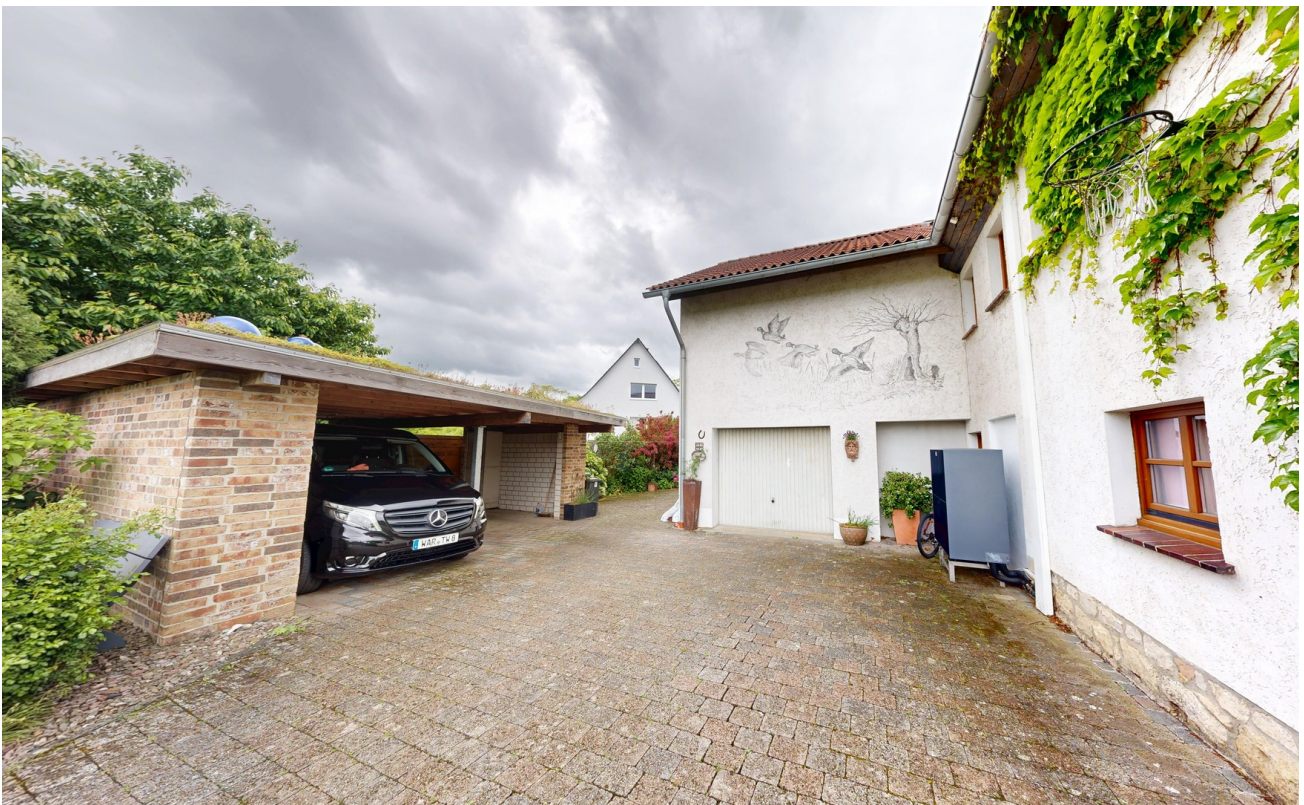
Carport, Garage, Wärmepumpe
