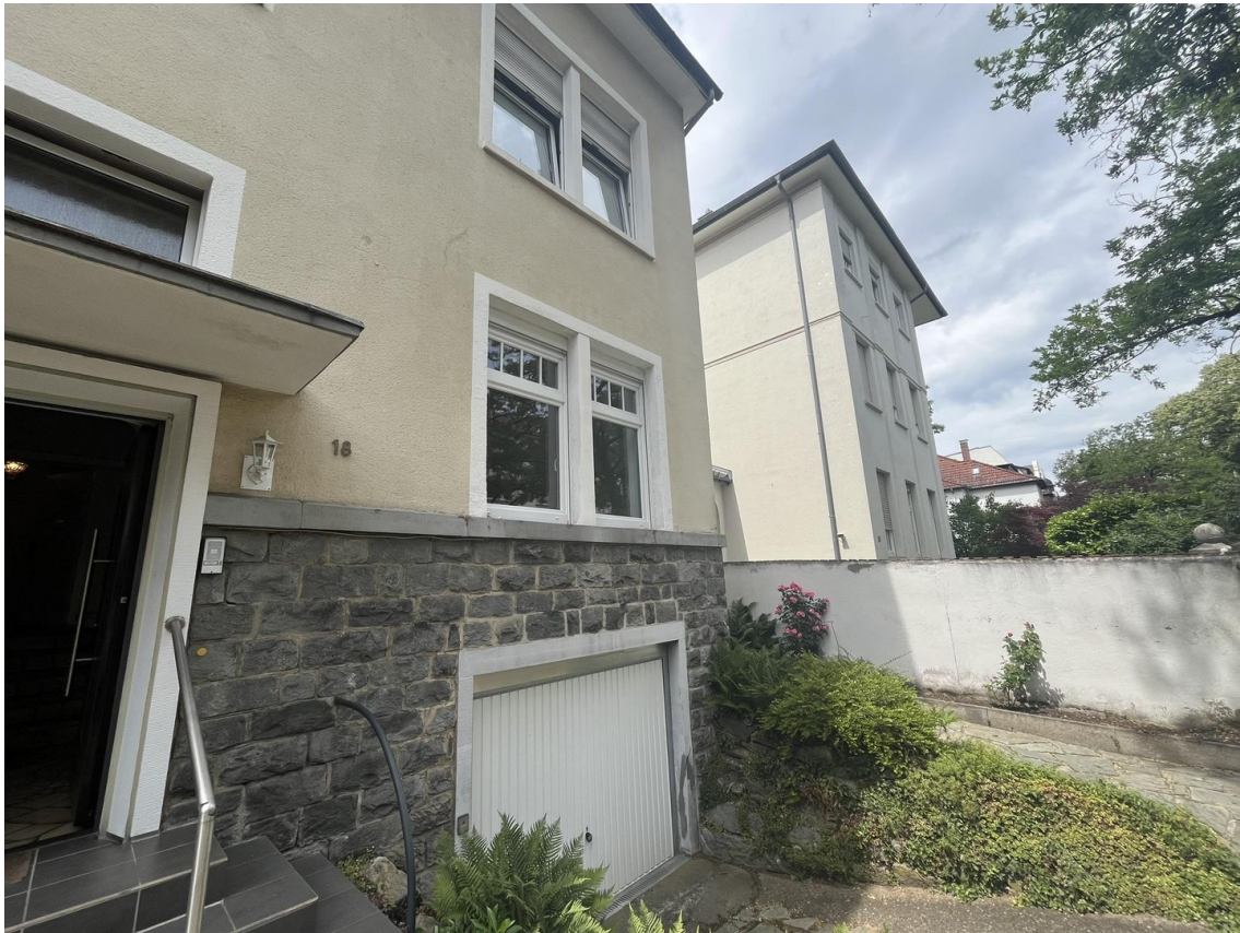
Garage zur EG Wohnung
