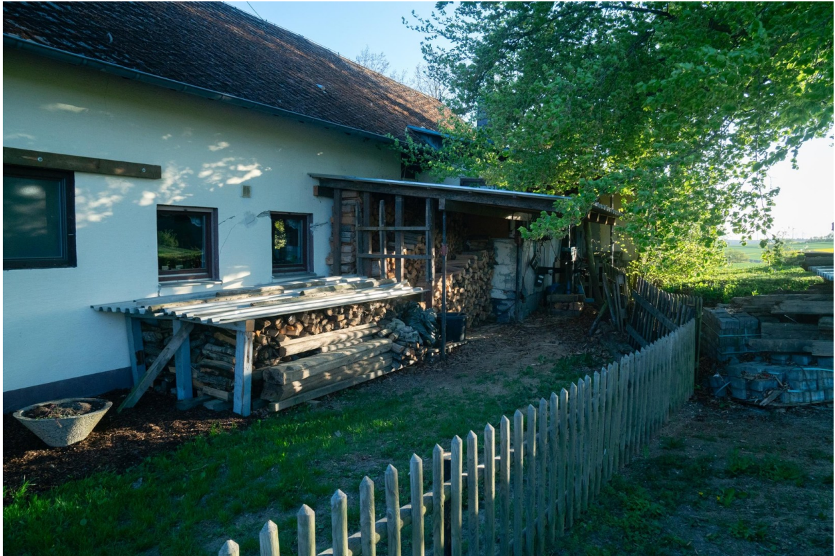
Nordseite mit Holzlager
