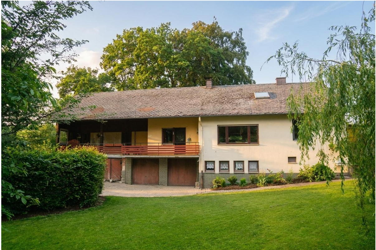
Haus Südseite mit Balkon
