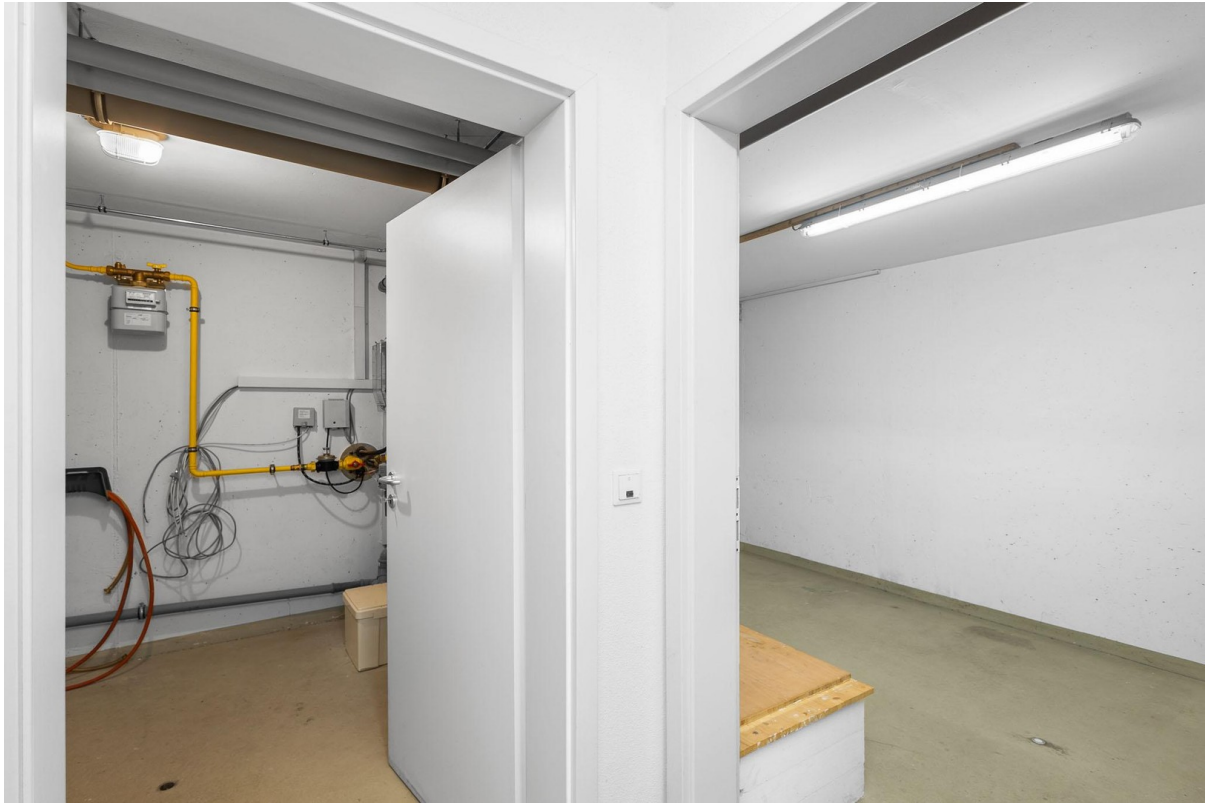
Blick auf Kellerräume
