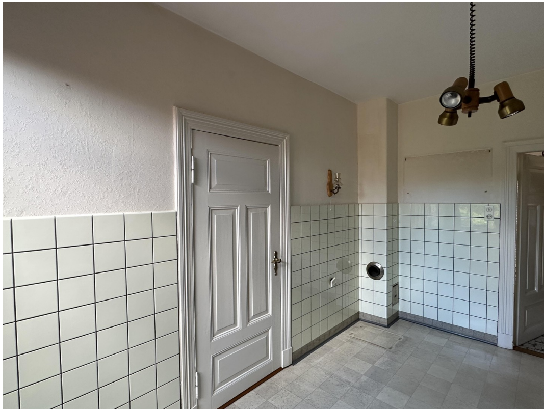
Küche, Durchgang Zimmer 3
