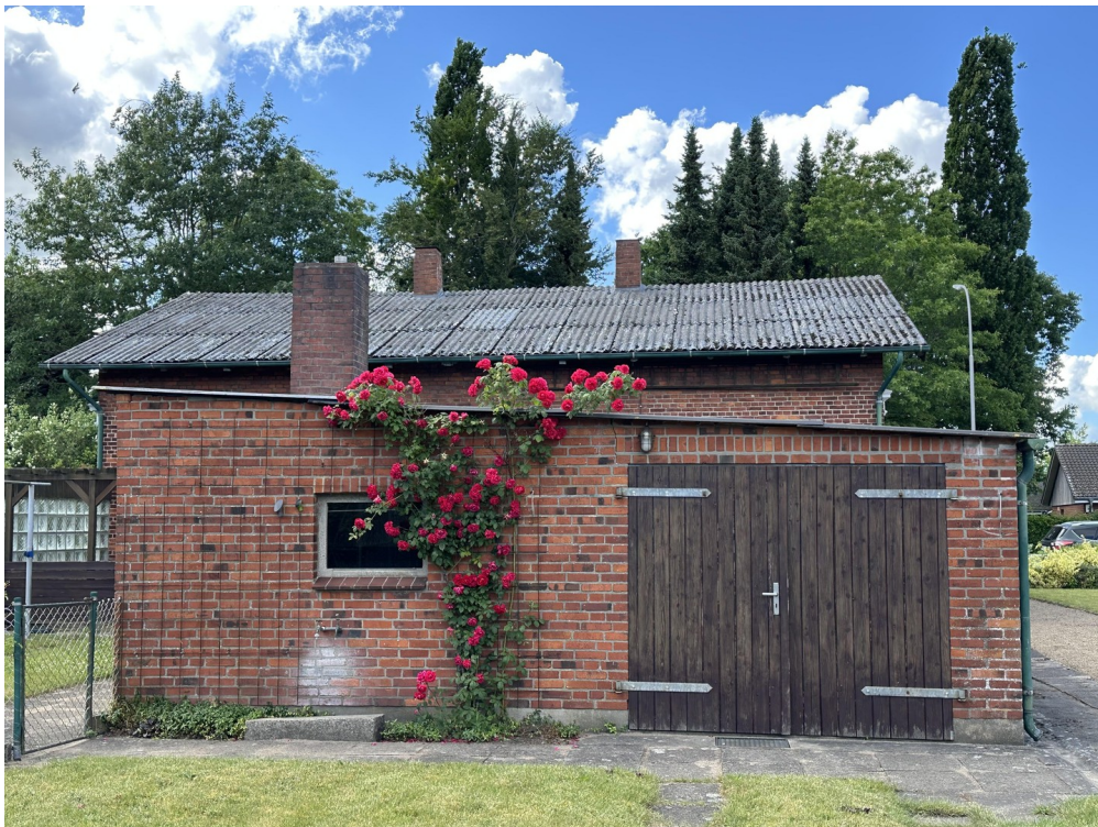
Anbau von hinten
