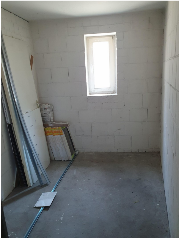
Keller mit Fenster
