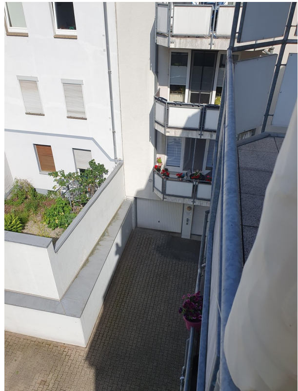
Garagenansicht vom Balkon
