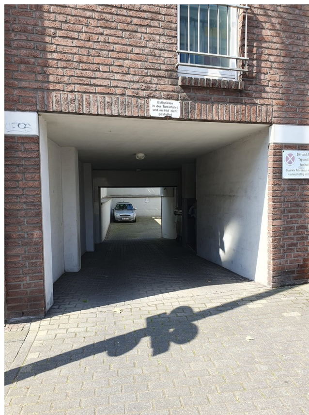
Garagenzufahrt von Straße
