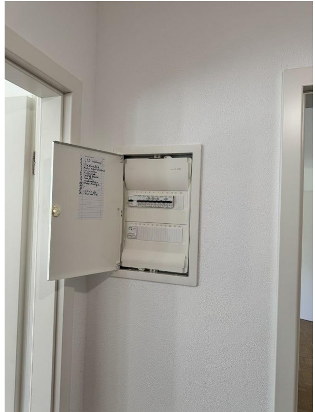
Strom/Sicherungskasten
