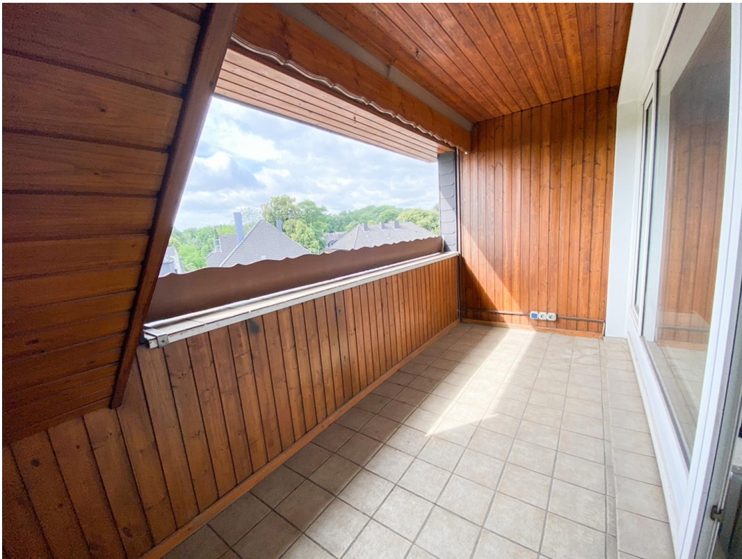
Ohne Möblierung Loggia
